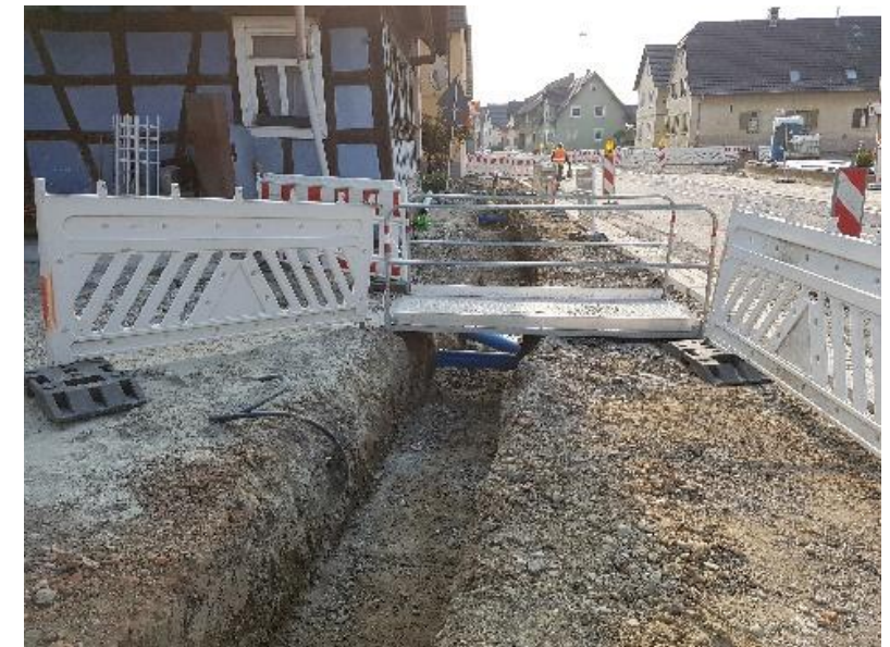
Erneuerung der unterirdischen Fahrbahnstruktur
