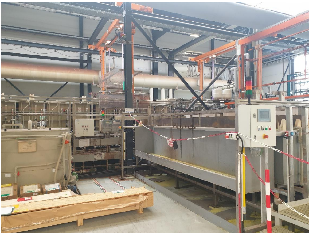
Abb. 4: Anlage in Betrieb, Fahrgestelle mit Teilen in den Tauchbädern
