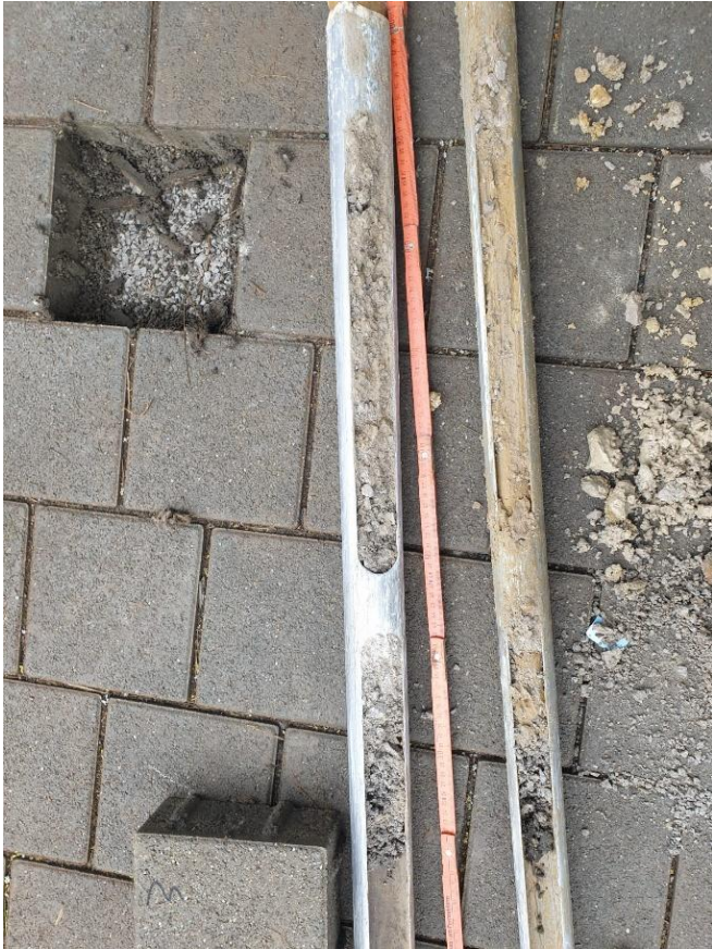
Foto Sondierung Z3
