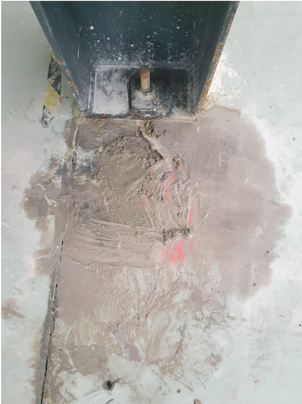
Abb. 37: Bohrstelle P7.1 verspachtelt
