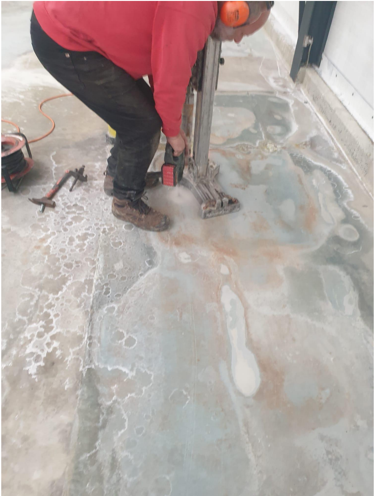
Abb. 25. Bohrung für die Arretierung des Bohrständers
