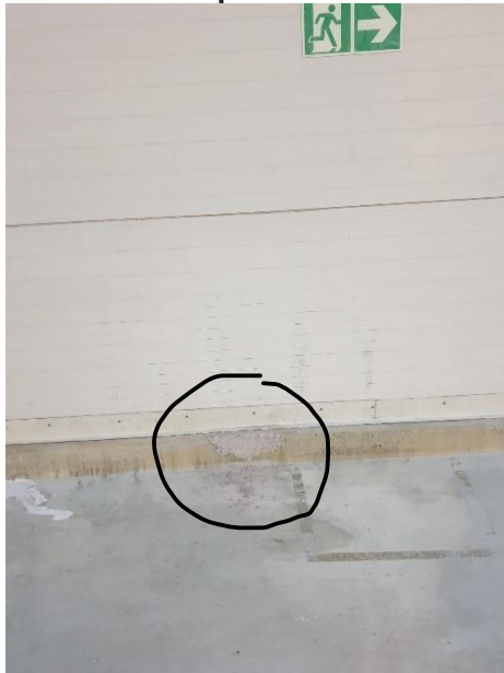
Abb. 33: Betonprobe aus Betonsockel P 13
