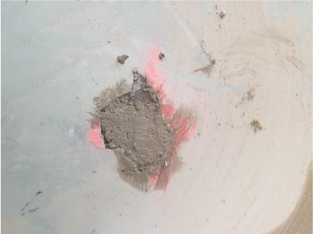
Abb. 26: Betonbohrung verfüllt
