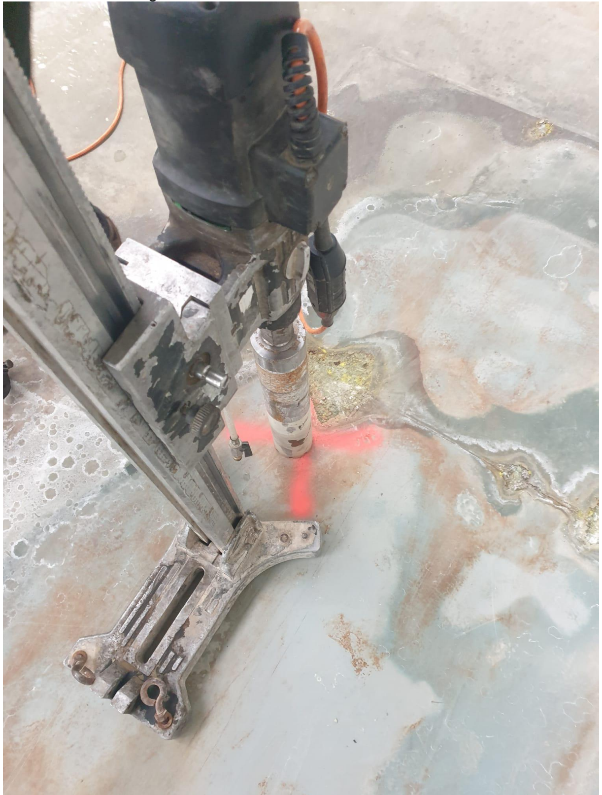
Abb. 24. P 28 Bohrung Betonkern
